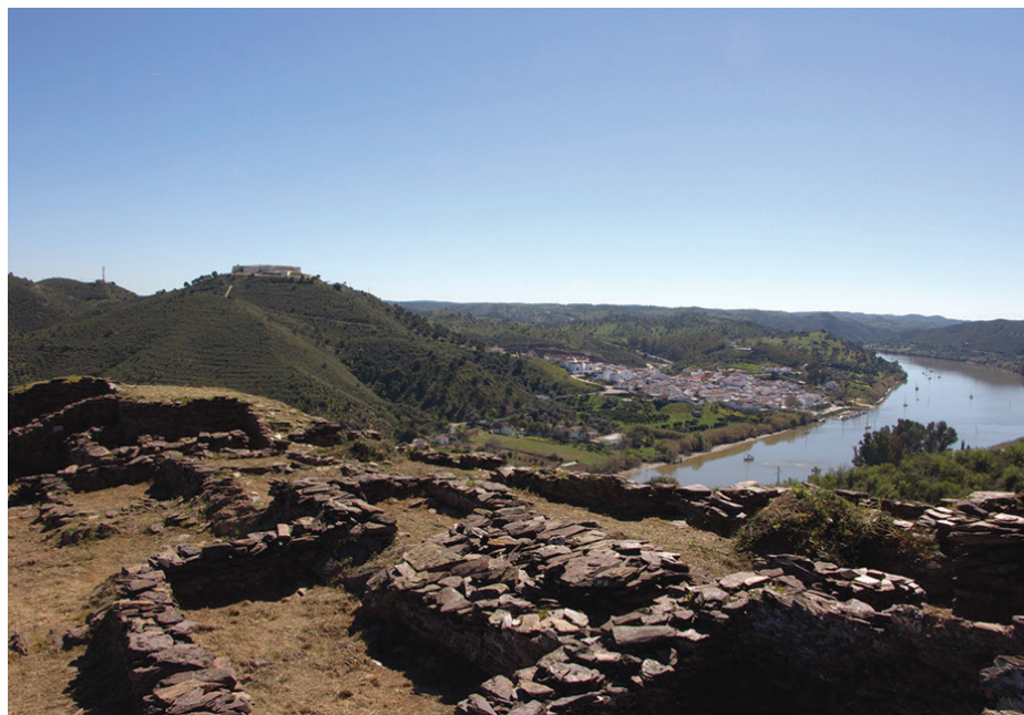
As obras no castelo decorrem até ao final de 2023
